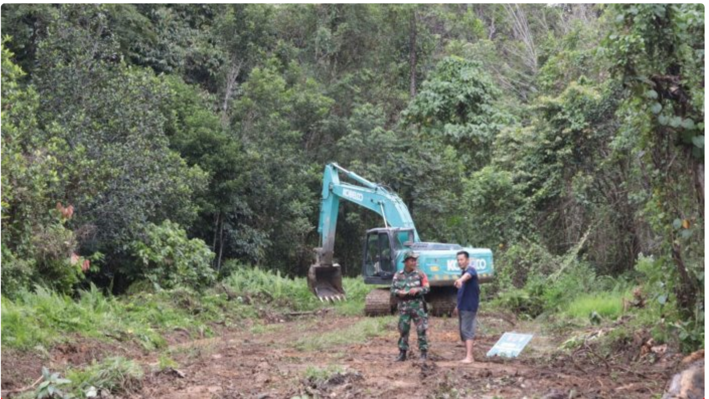
Wujudkan Aspirasi Warga, TMMD Wiltas 118 Kodim 0910/ Malinau Bangun Jalan Baru
