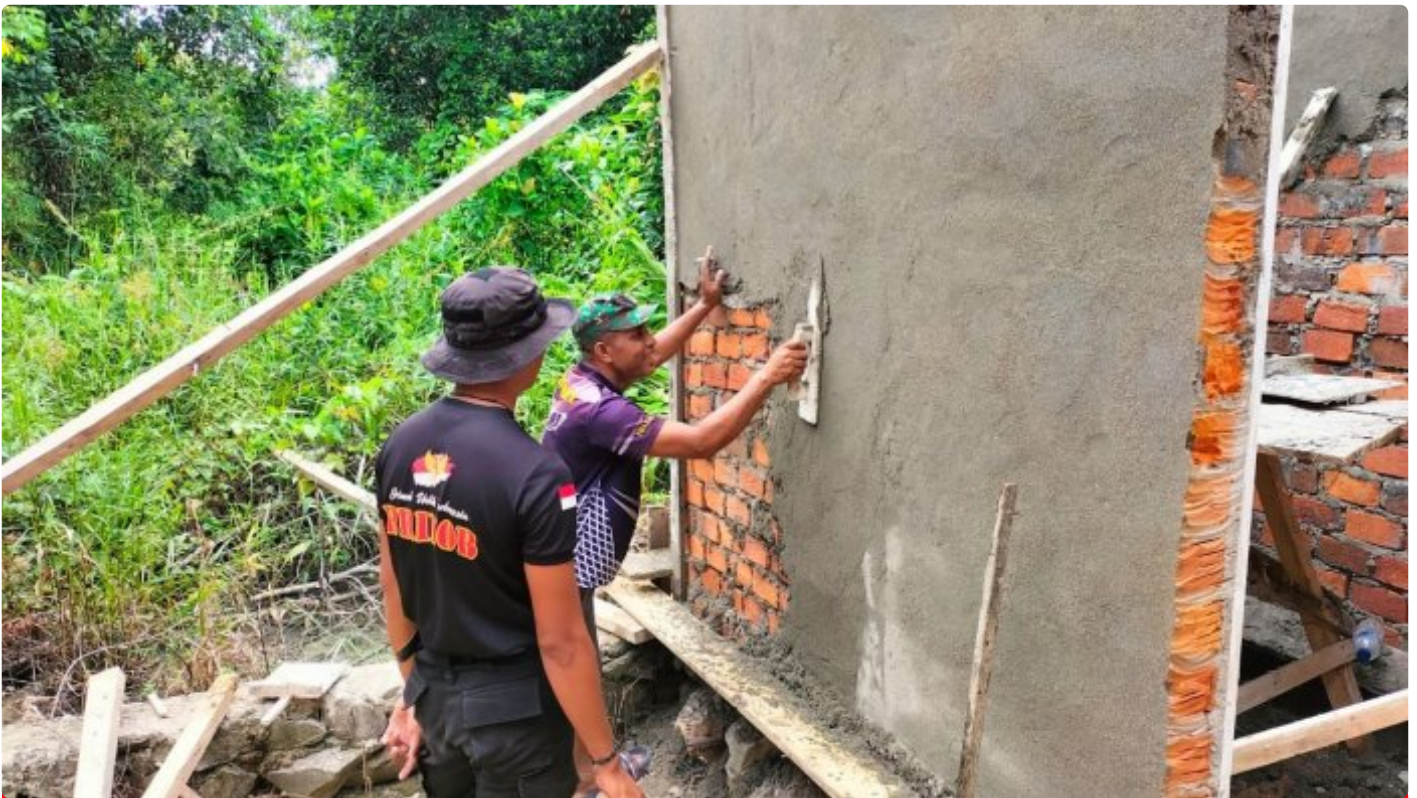
Satgas TMMMD Ke- 118 Wiltas Kodim 0910/Malinau Plester Dinding Pembangunan MCK Gereja
