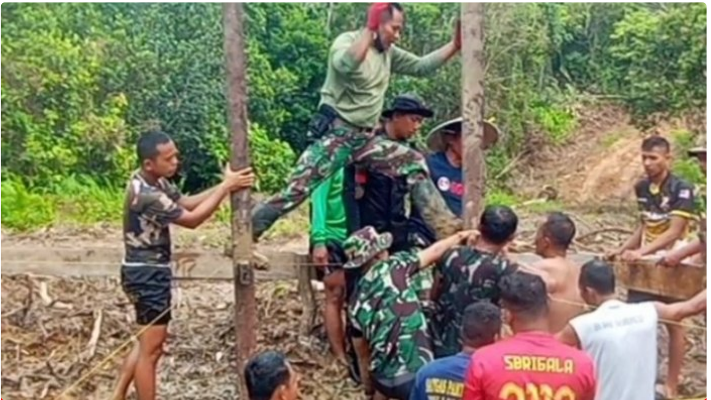
Satgas TMMD ke- 118 Wiltas Kodim 0910/Malinau Pasang Tiang Pancang Jembatan
