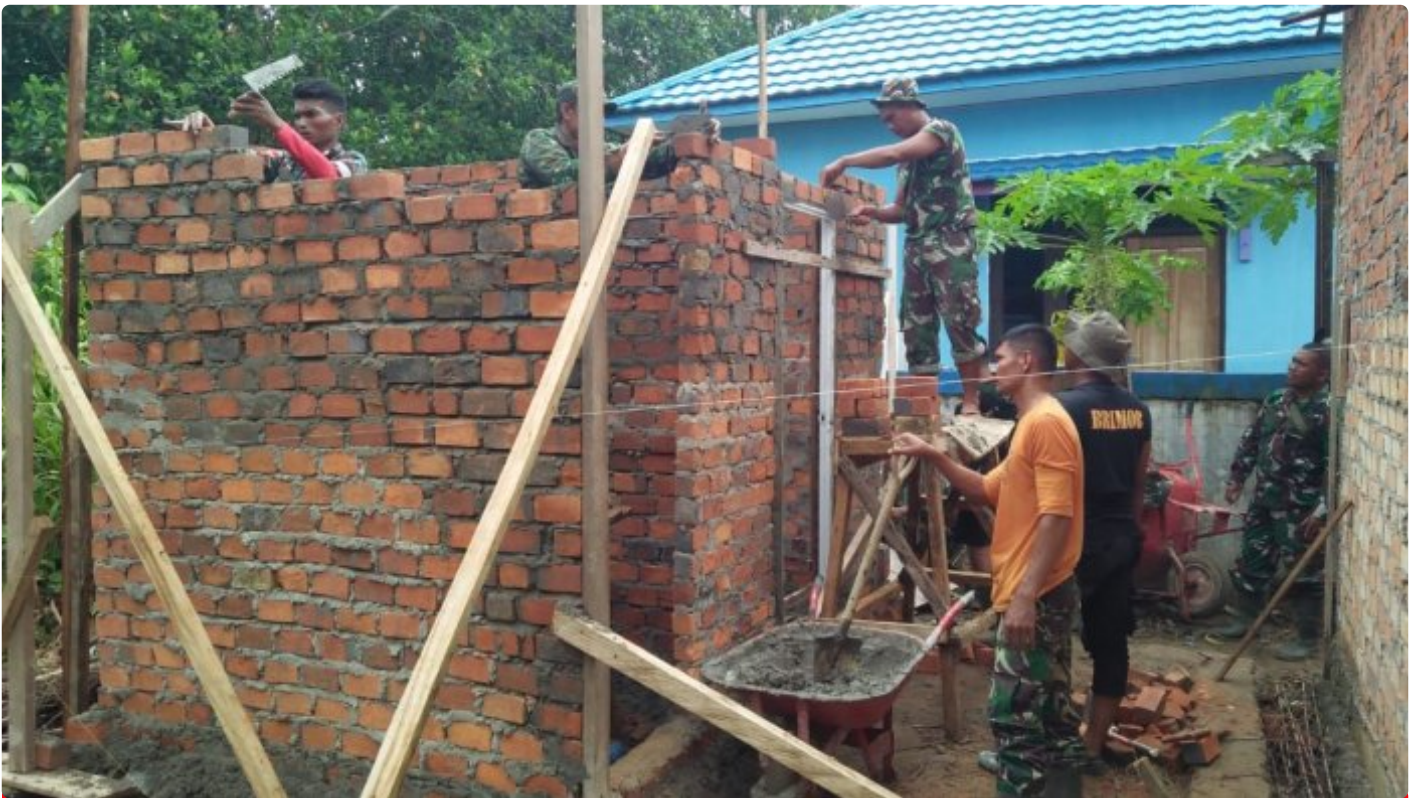
Pasiter Tinjau Proses Pekerjaan Sasaran Tambahan TMMD ke-118 Pembangunan MCK Gereja
