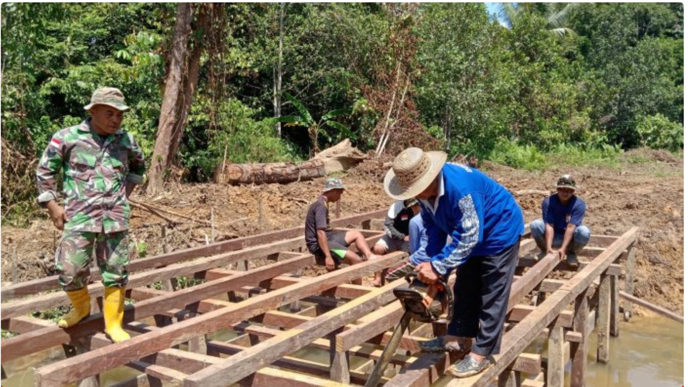
Kepala Desa Kaliamok Terjun Langsung Bersama Warga Bantu Satgas TMMMD ke- 118 Membuat Jembatan
