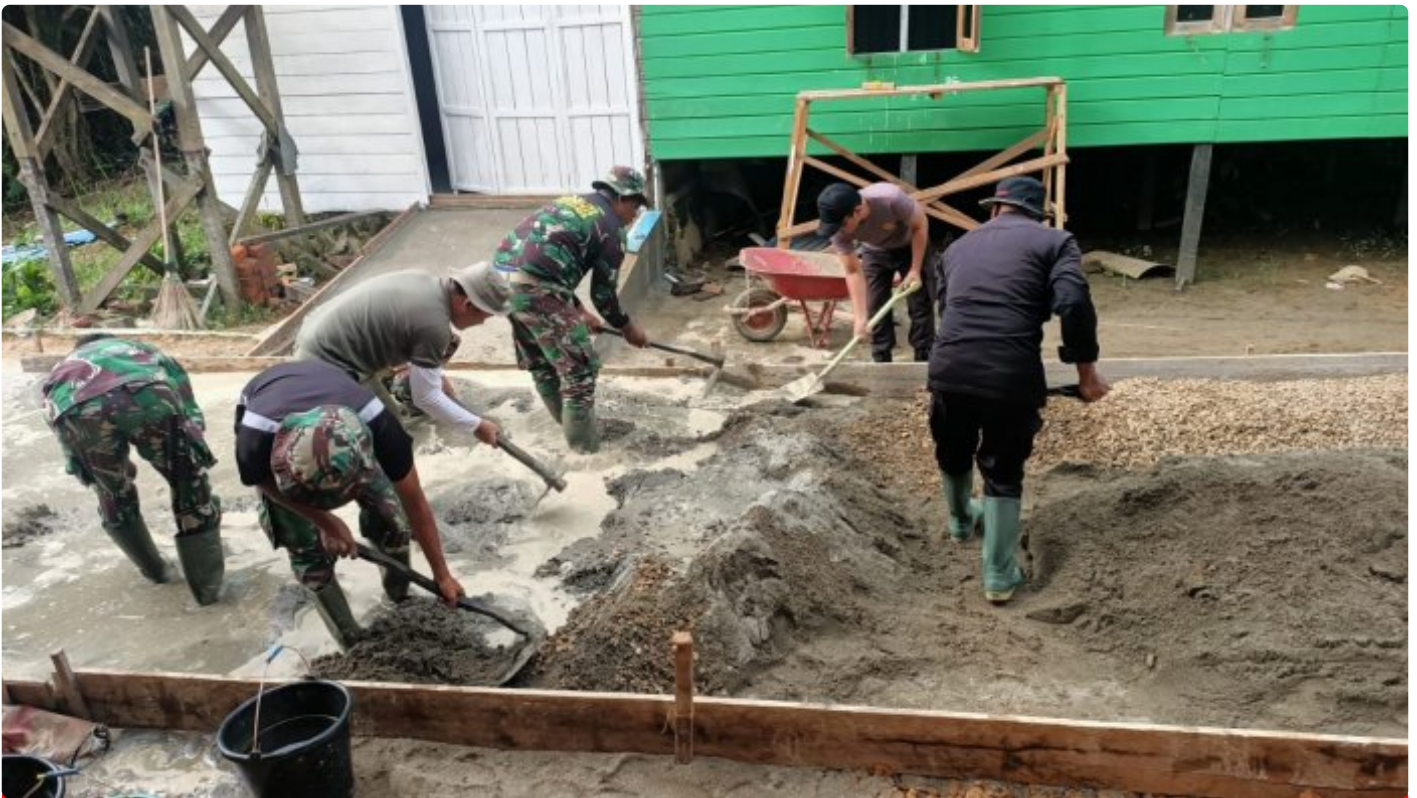
Aduk Semen Dengan Cangkul dan Skop Kebut Pembangunan Semenisasi Jalan TMMMD
