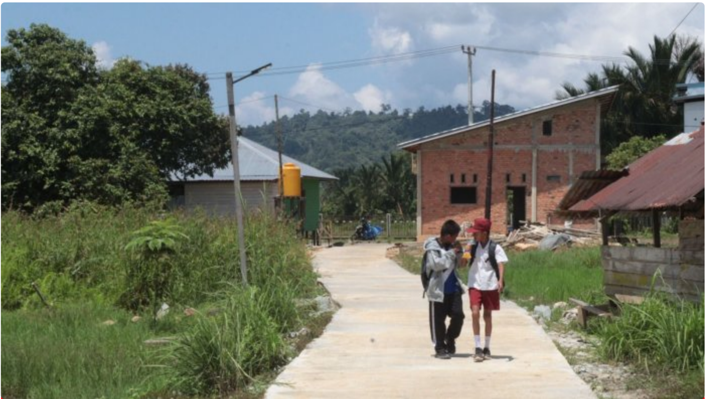
2 Hari Jelang Penutupan TMMD Ke- 118 Sasaran fisik Semenisasi Jalan Selesai 100 Persen
